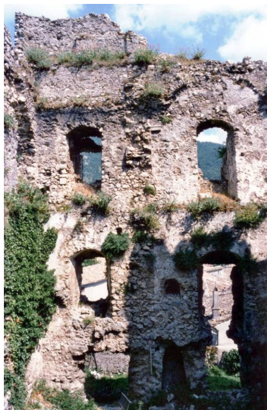
Vista interna, in sommità si intravedono le imposte delle volte.
