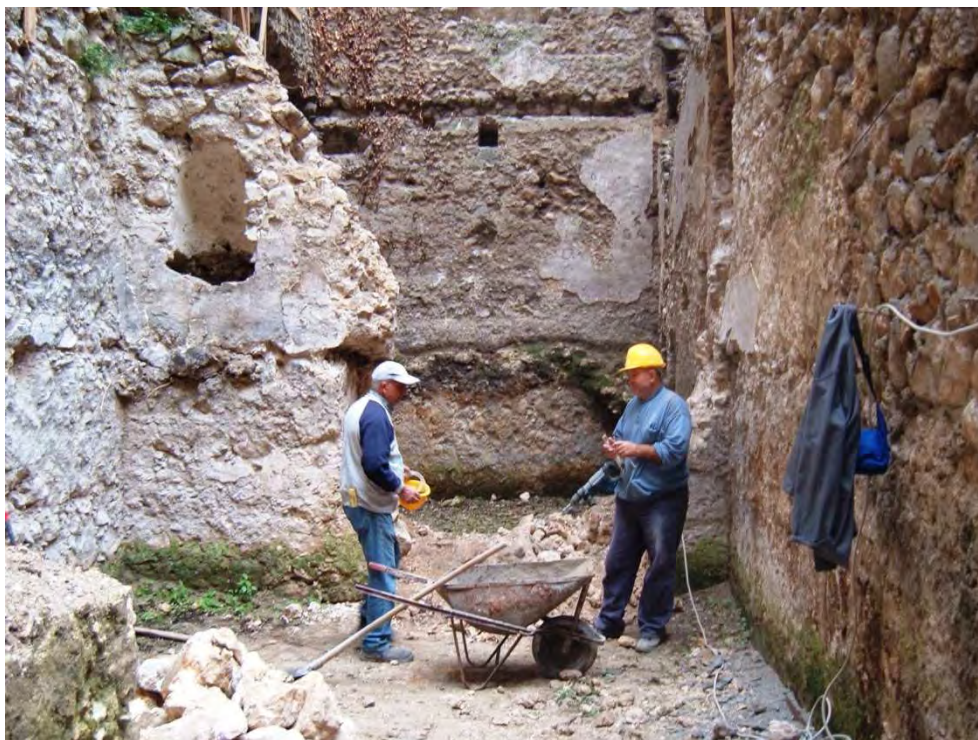
Figura 7 - Sul fondo è visibile una delle due cisterne del castello, un tempo chiusa con volta a botte.
