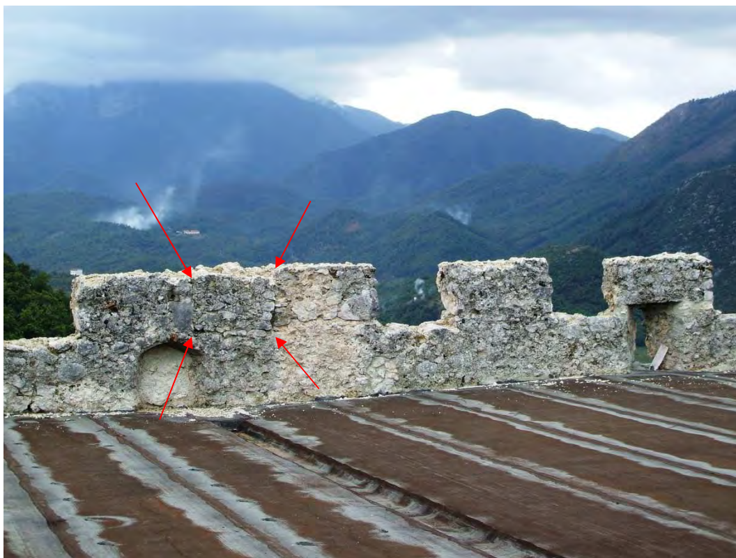
Figura 6 - Nell'immagine è ben visibile la muratura che ha chiuso la merlatura originaria
