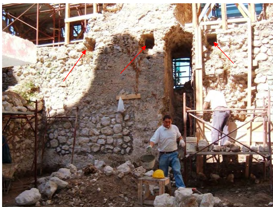
Figura 3 - Alloggi delle travi originarie della prima orditura
